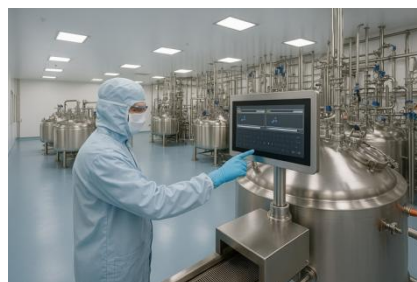
生物制药洁净车间
